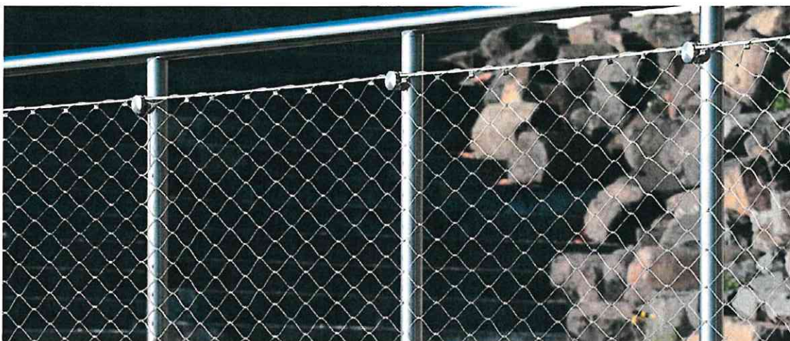
fig. 2 - esempio di rete di tamponatura in acciaio
