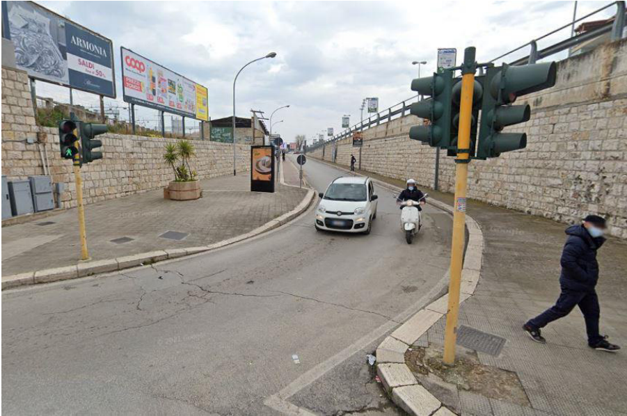
Vista da Via Alvisi verso Via V. Veneto
