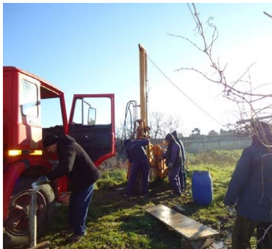
Foto 18. Esecuzione del sondaggio P3
