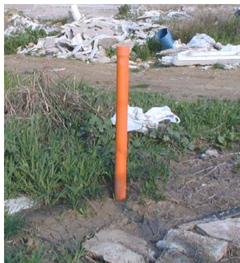
Foto17. Tubo piezometrico del sondaggio P1
