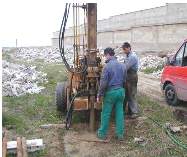
Foto 16. Esecuzione del sondaggio P1
