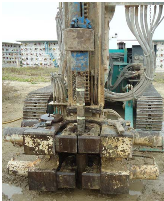
Foto 5 – Ubicazione sondaggio S2 ed esecuzione di una delle due prove SPT effettuate ad 1,0 m e 4,5 m dal p.c.
