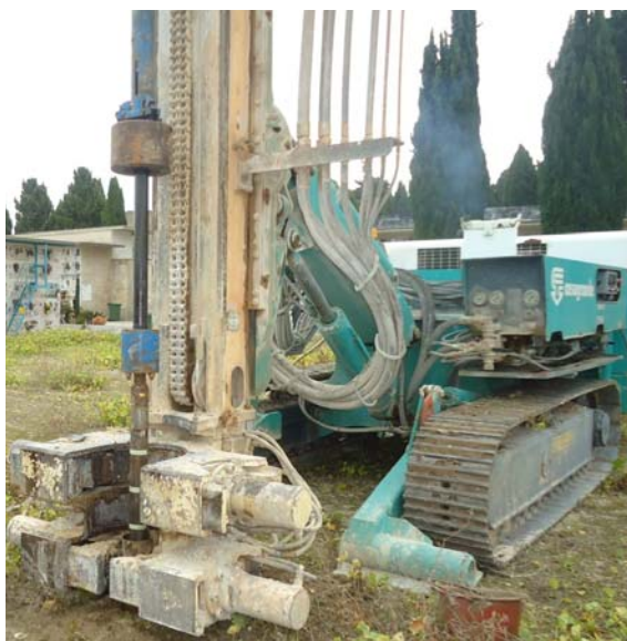
Foto 1- Ubicazione sondaggio S1 ed esecuzione prova SPT da 1,5 m a 1,95 m
