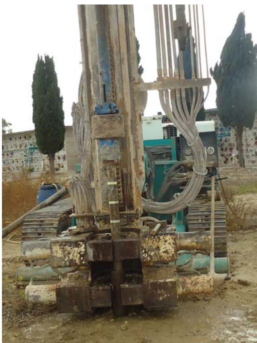
Foto 9 – Ubicazione sondaggio S3 ed esecuzione della prova SPT da 2,5 m a 2,95 m
