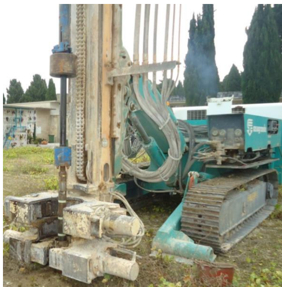
Foto 7- Ubicazione sonadggio S1 ed esecuzione prova SPT da 1,5 m a 1,95 m
