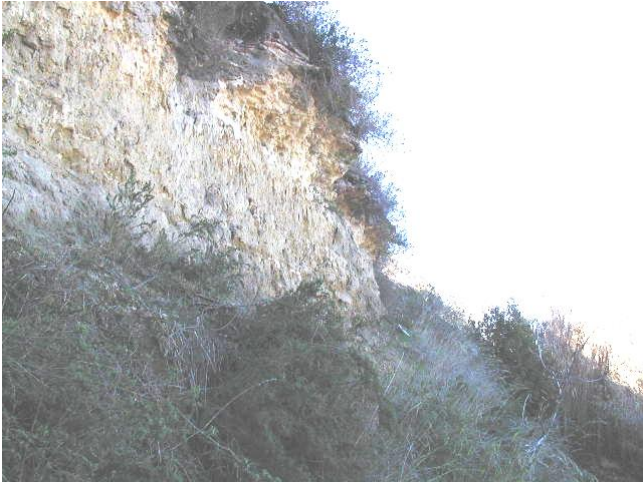
Foto 1 - Unità della scarpata naturale ed in particolare l'unità calcarenitico sabbiosa (Unità CS) al di sopra di quella limoso-argillosa (Unità LA) (Sezioni 1-6)
