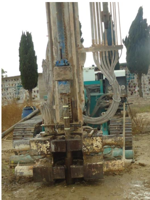
Foto 15 – Ubicazione sondaggio S3 ed esecuzione della prova SPT da 2,5 m a 2,95 m
