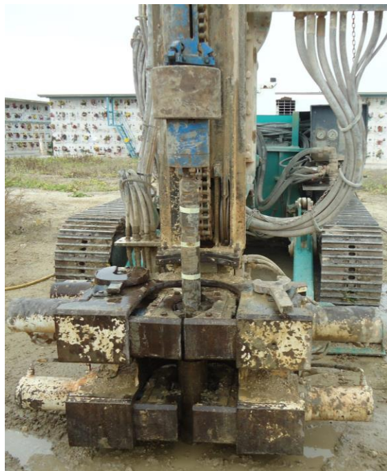
Foto 11 – Ubicazione sondaggio S2 ed esecuzione di una delle due prove SPT effettuate ad 1,0 m e 4,5 m dal p.c.
