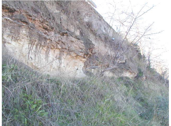
Foto 2 - Erosione differenziale nell'ambito dell'Unità CS della crosta rispetto alla sabbia calcarea sottostante (Sezioni 1-6)
