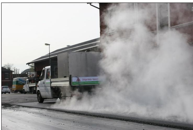
Fig.4.2.a Spruzzo della vernice foto catalitica sulla pavimentazione appena realizzata
