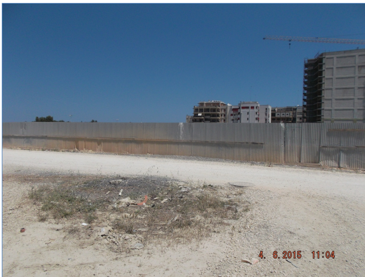
Figura 18.a Zona di progetto parzialmente recintata per la realizzazione di un cantiere edile previsto da piano regolatore
