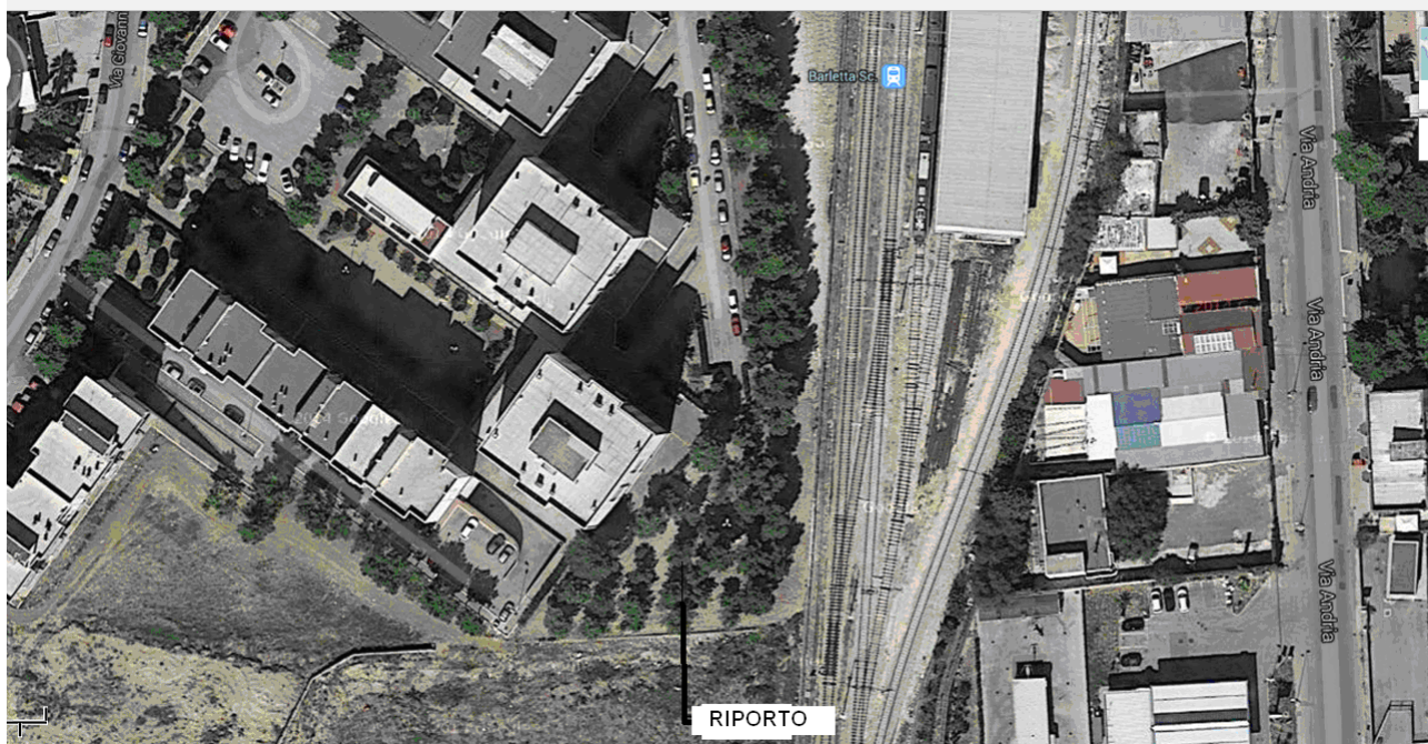
Condomino posto a nord dell'area di interesse – nuova sistemazione del terreno.
