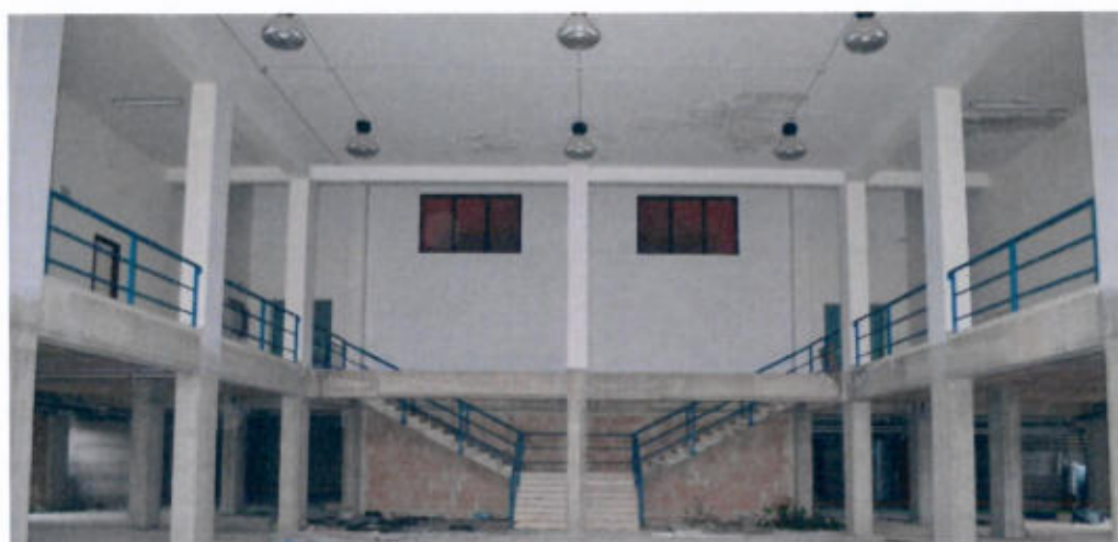
Fig. 4 – CORPO BASSO - Vista Interna
