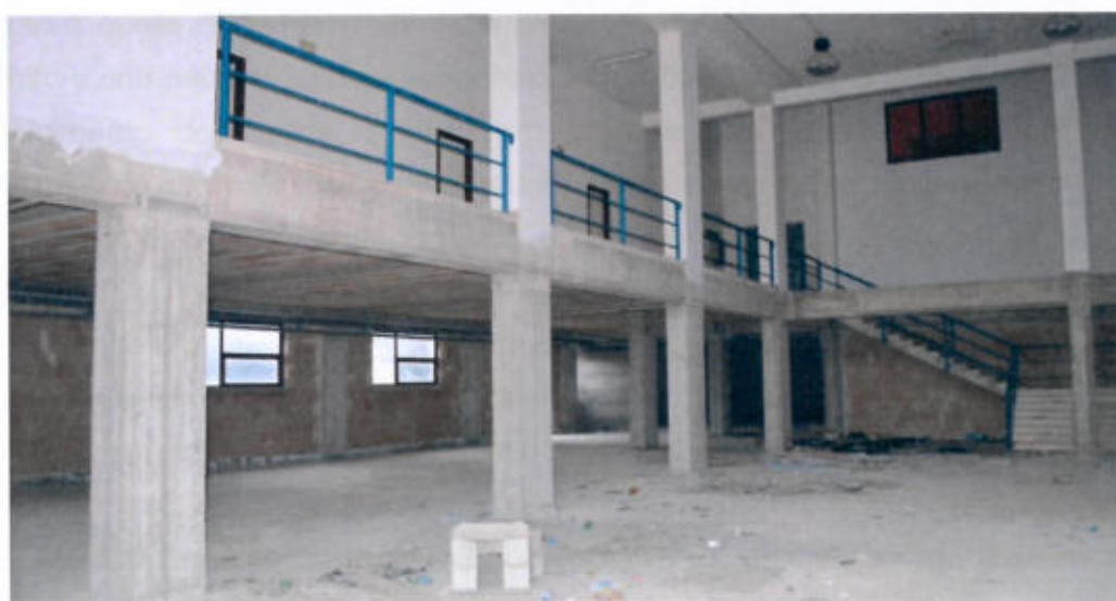
Fig. 5 – CORPO BASSO - Vista Interna
