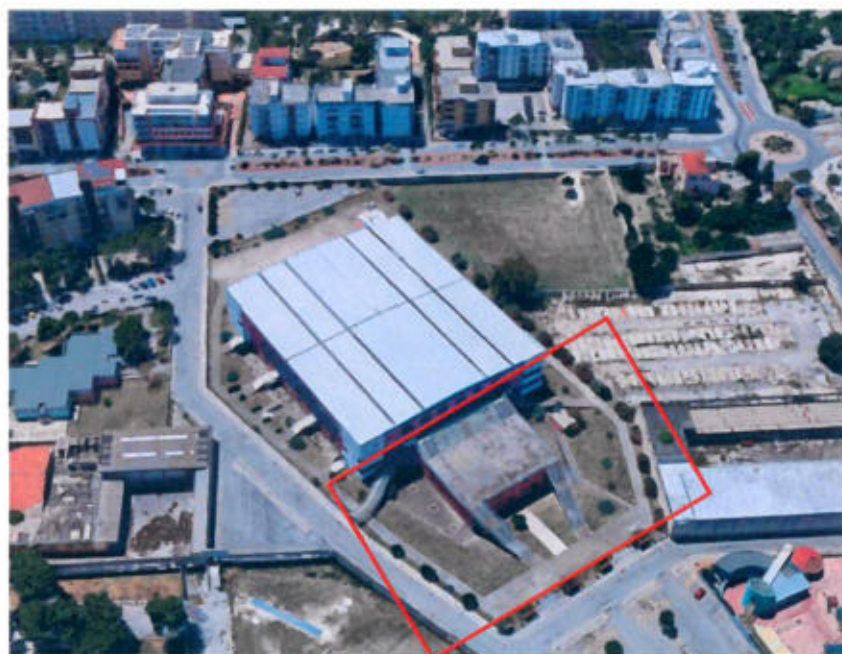
Foto 2 : Impianto Sportivo - Area di Cantiere
