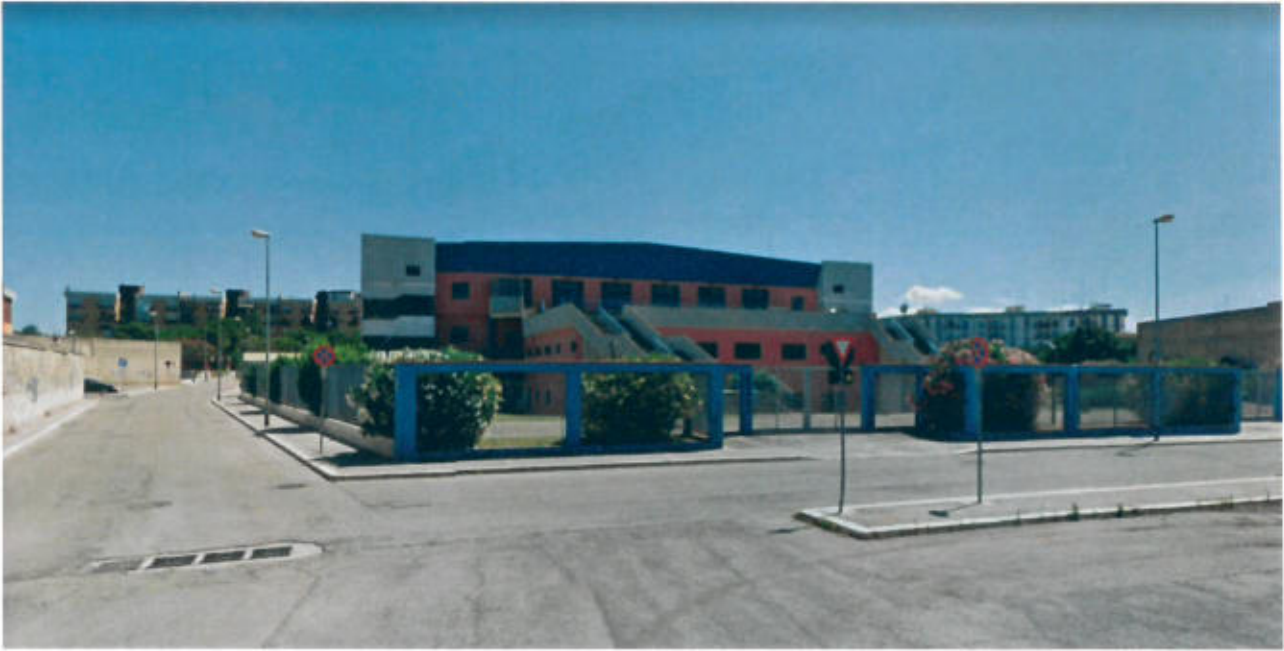
Foto 3 : Accesso - Area di Cantiere
