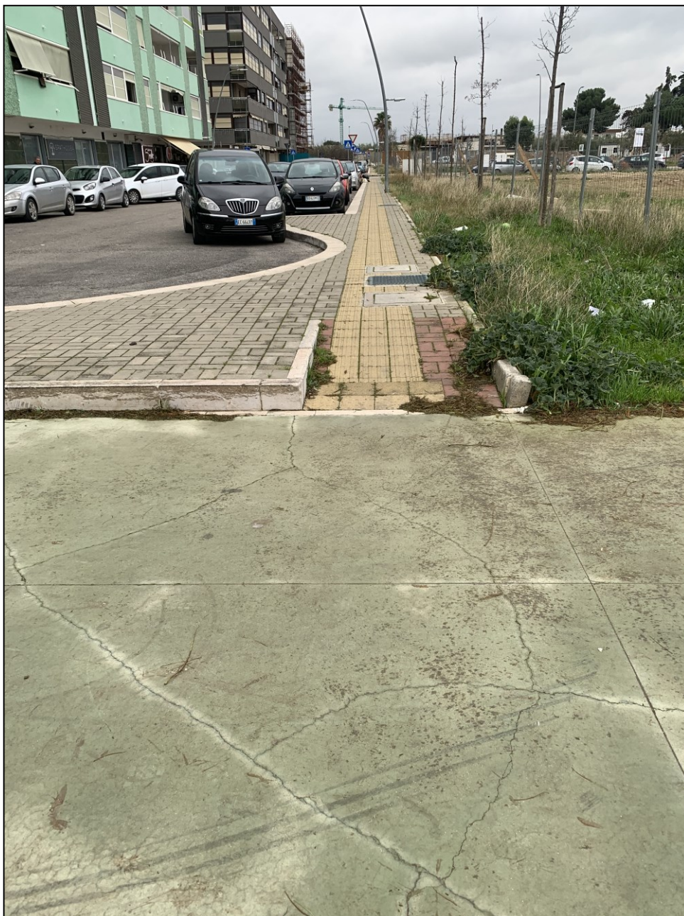
Foto n.1 - ripresa da via R. Livatino (a dx area oggetto d'intervento)
