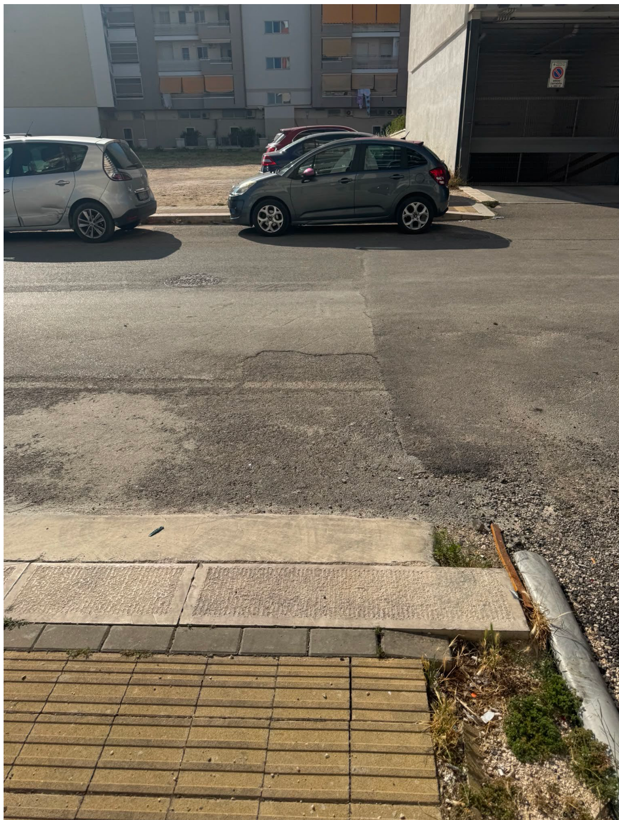
Stato di fatto di via Tommaso Capossole
