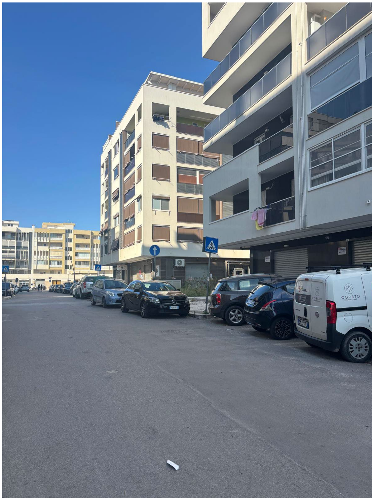
Stato di fatto di via Tommaso Capossole
