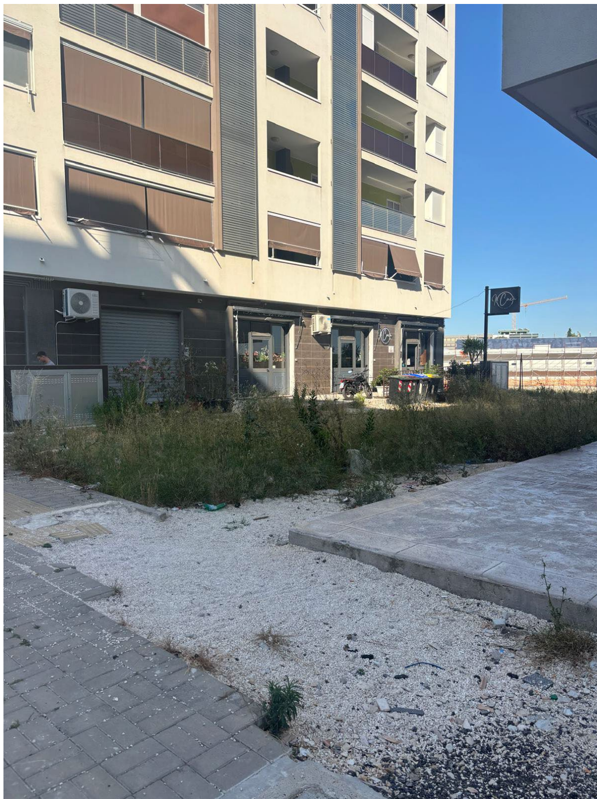
Stato di fatto di via Tommaso Capossole
