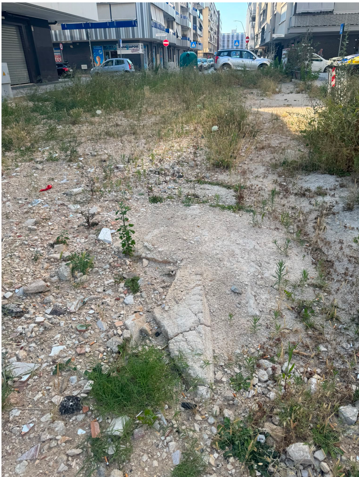
Stato di fatto di via Tommaso Capossole
