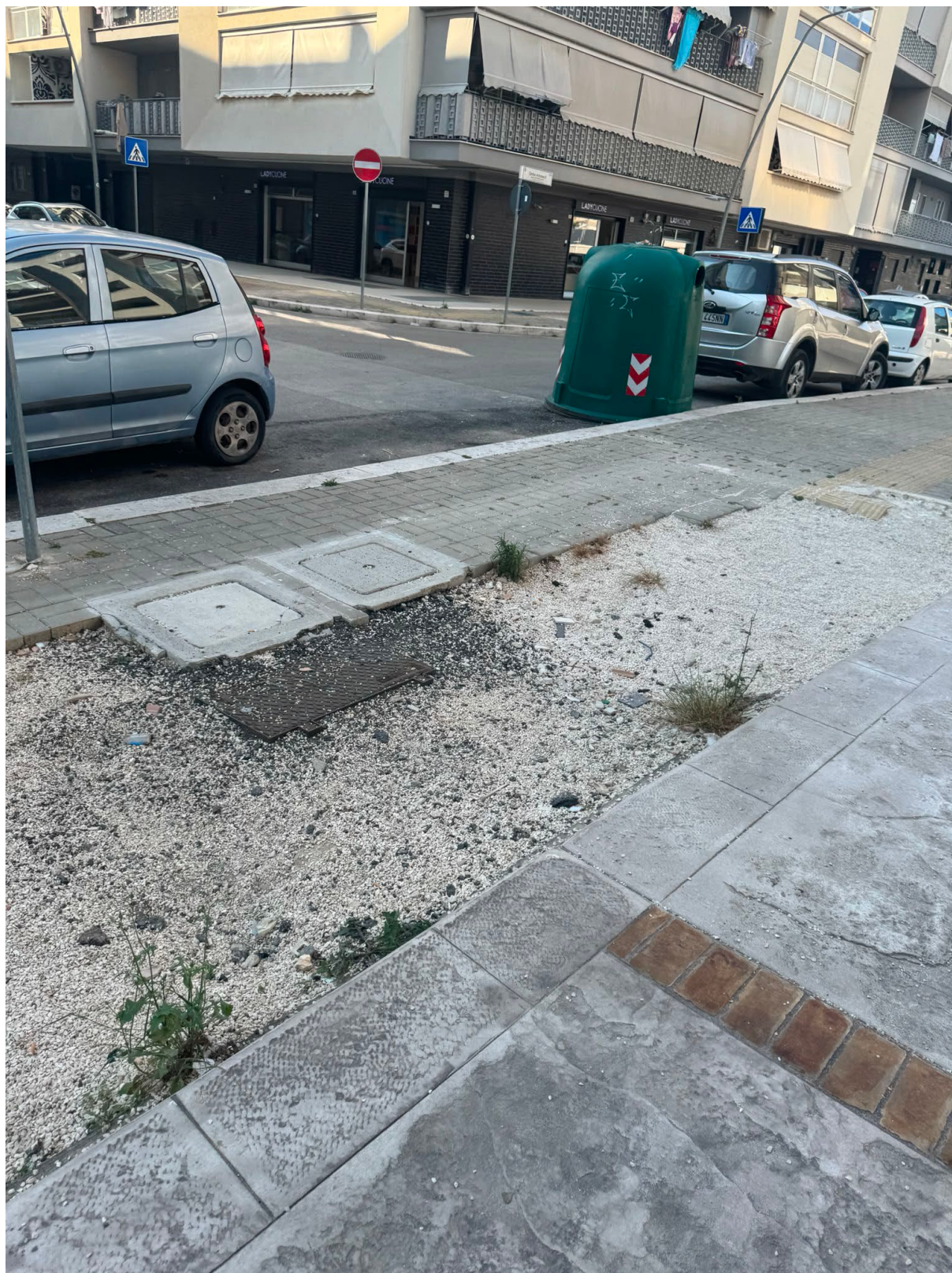
Stato di fatto di via Tommaso Capossole
