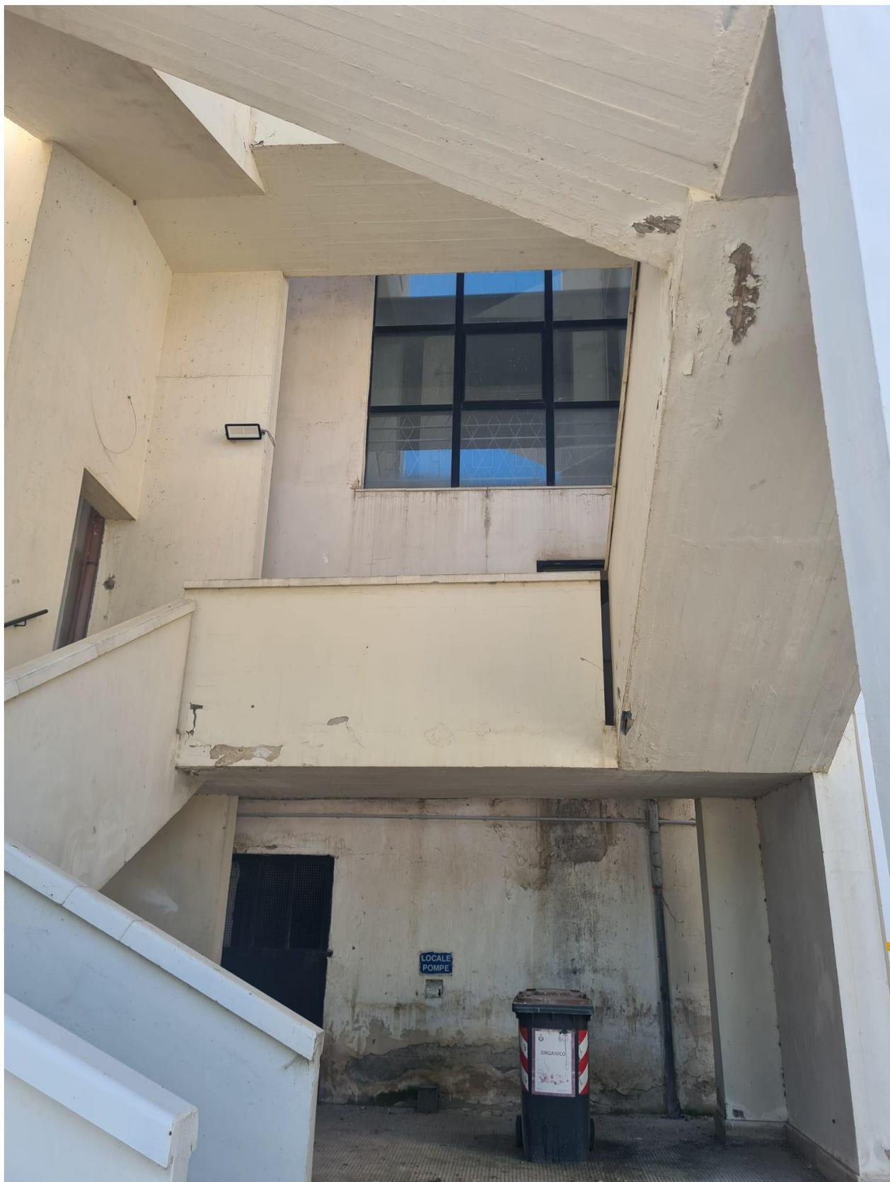
Scala di emergenza da ripristinare con risanamento delle zone ammalorate e dei copriferri.
