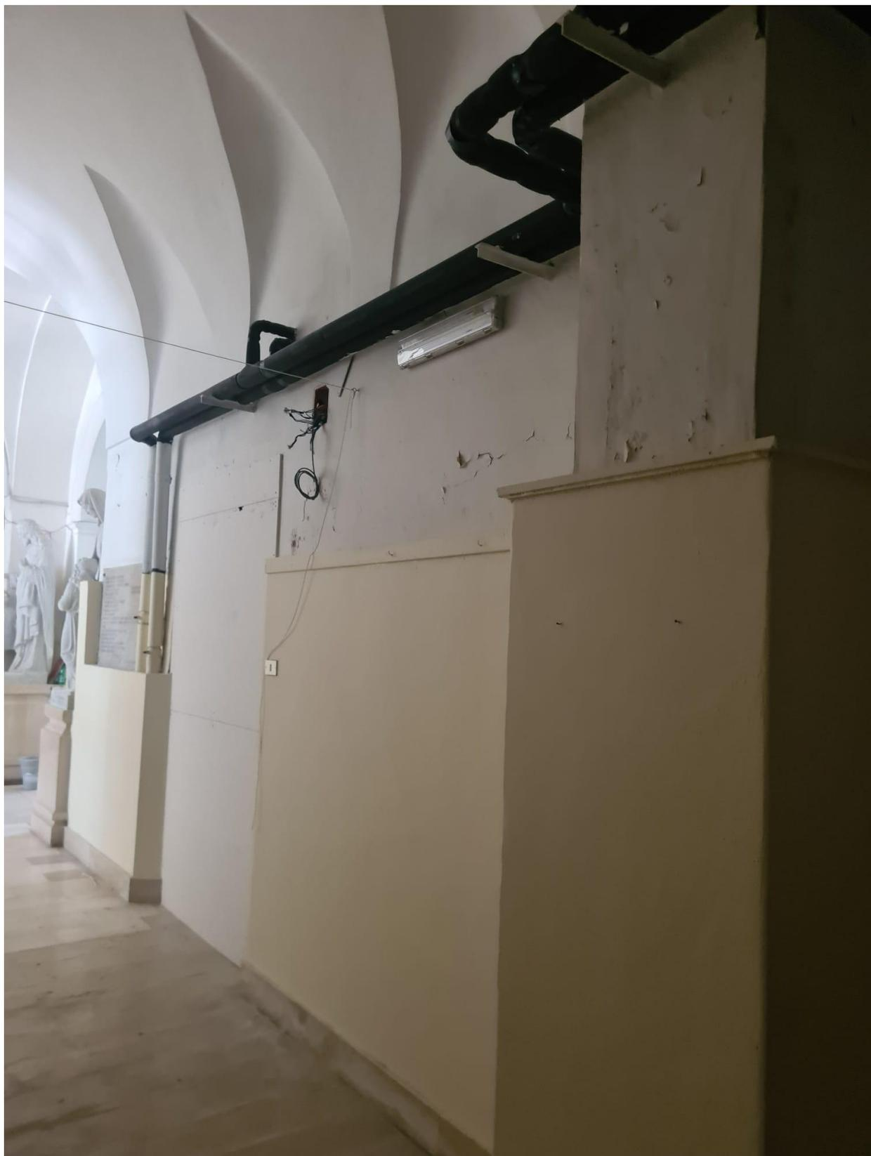
Pitture e intonaci ammalorati da spicconare e ripristinare e contropareti in muratura esistenti su cui passeranno canaline per realizzazione dei necessari punti rete ed elettrici funzionali alla scuola.
