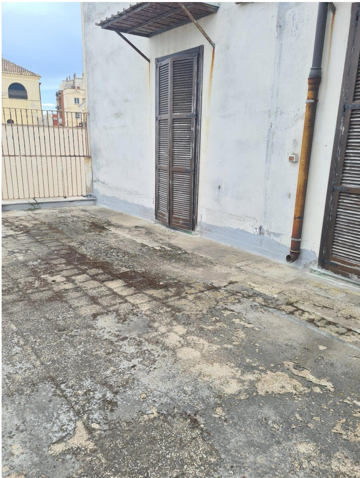
Terrazzo primo piano su cui verrà rifatto sottofondo guaina e pavimentazione calpestabile e ripristino della facciata con rimozione di intonaci ammalorati e ritinteggiatura.
