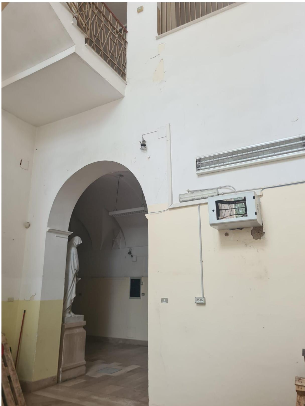
Vano scala centrale con posizionamento RACK già esistente che verrà ripristinato e con opportune canalizzazioni verrà collegato al RACK presente al primo piano.
