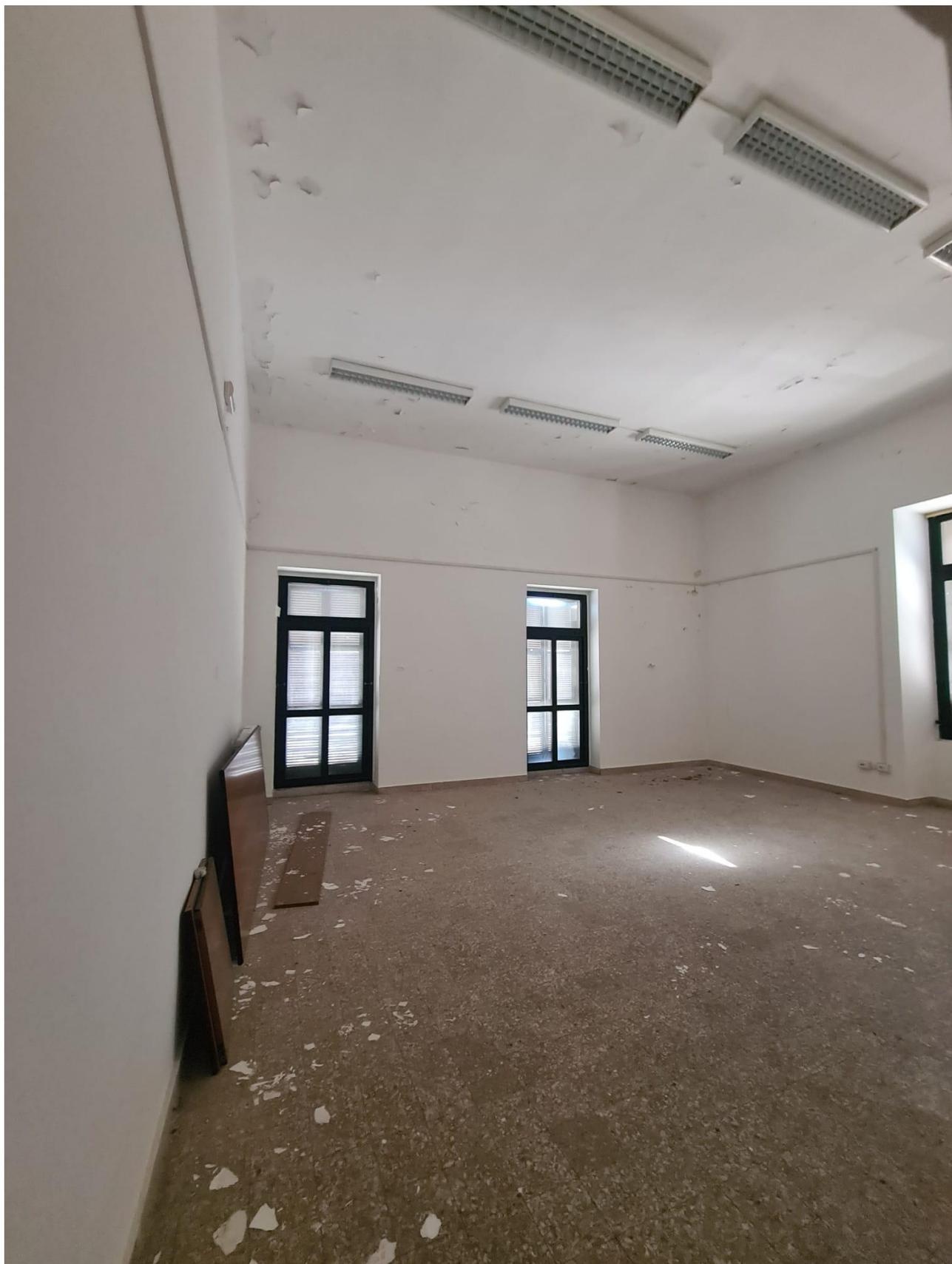
Aule con pittura distaccata da ripristinare mediante carteggiatura rasatura e tinteggiatura.
