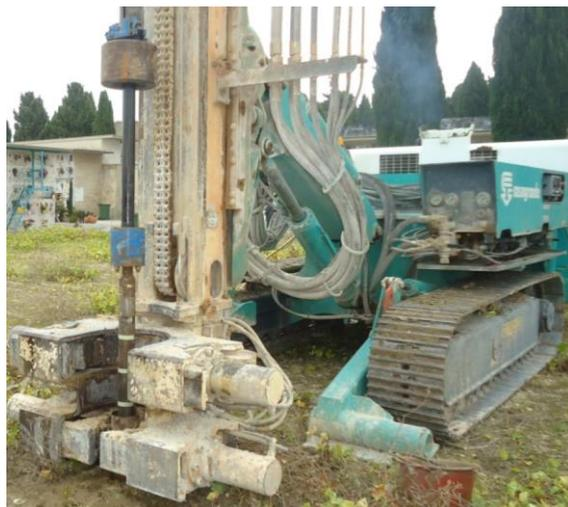
Foto 7 - Ubicazione sondaggio S1 ed esecuzione prova SPT da 1,5 m a 1,95 m
