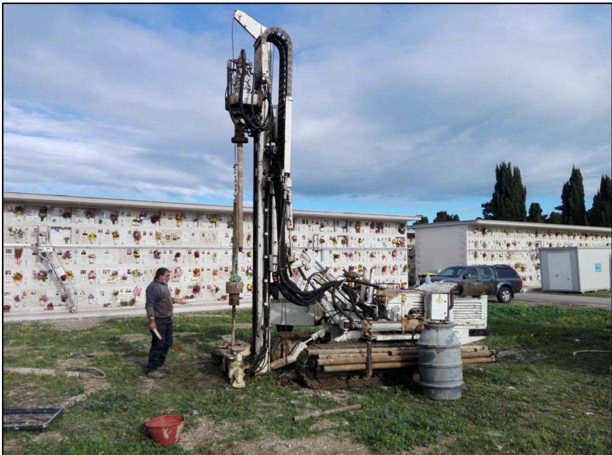
Trivella utilizzata (modello GEO 405 della Comacchio S.r.l.)
