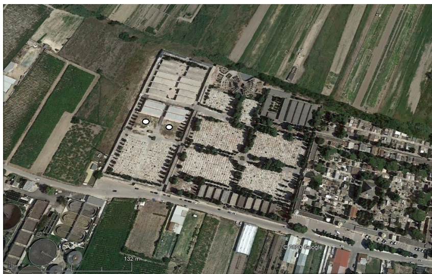
Figura 1 - Ubicazione dell’area interessata dalla realizzazione dei 1160 loculi all’interno del Cimitero di Barletta – Immagine da Google Earth.
