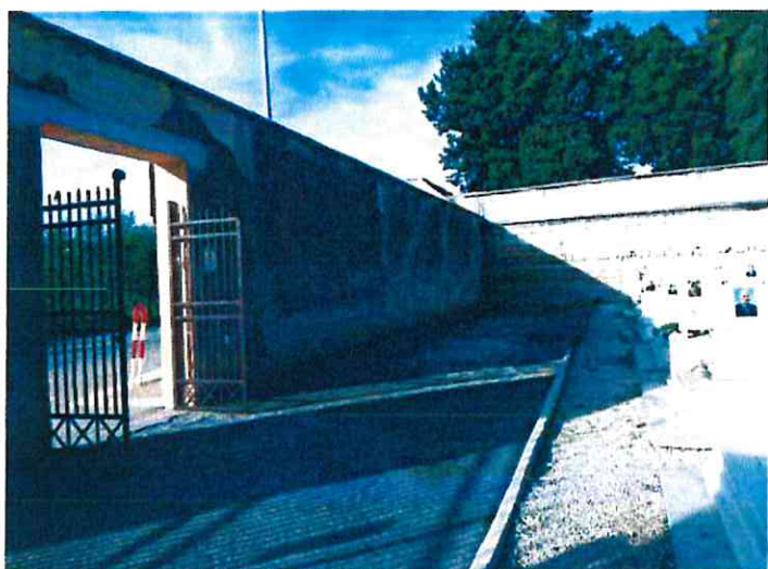
(Figura 4 - stato di fatto)
