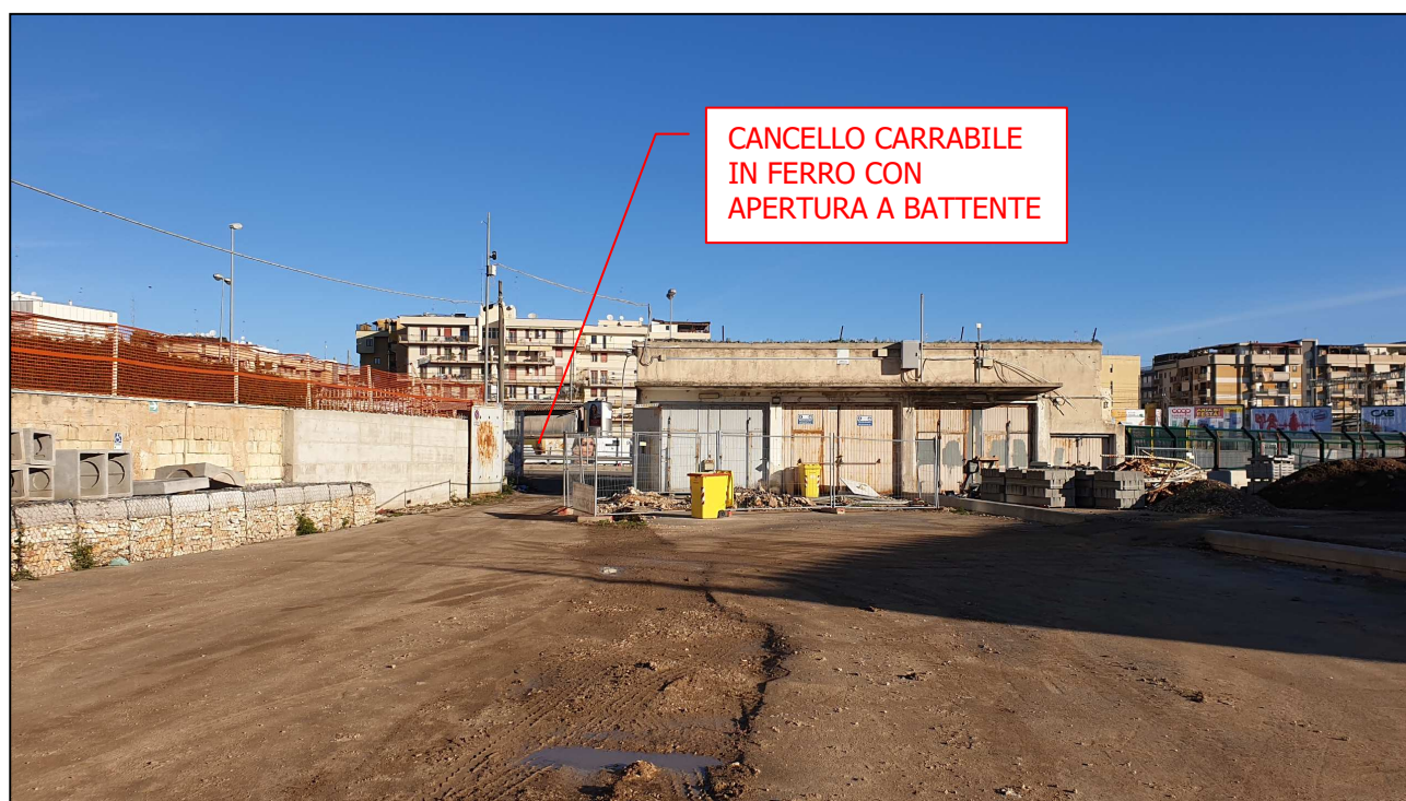
Fig. 4: vista dall'interno dell'ingresso al cantiere
