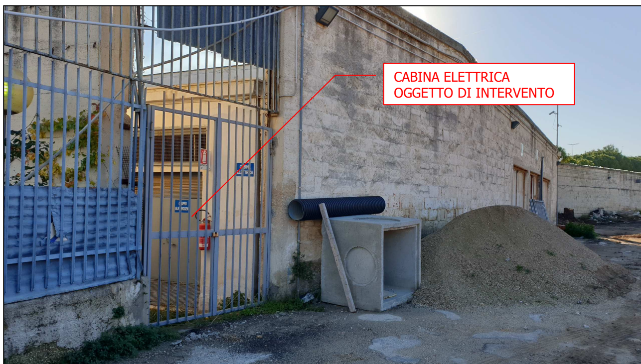
Fig. 6: vista della cabina elettrica oggetto di intervento sita lungo il lato NORD-EST dello stadio
