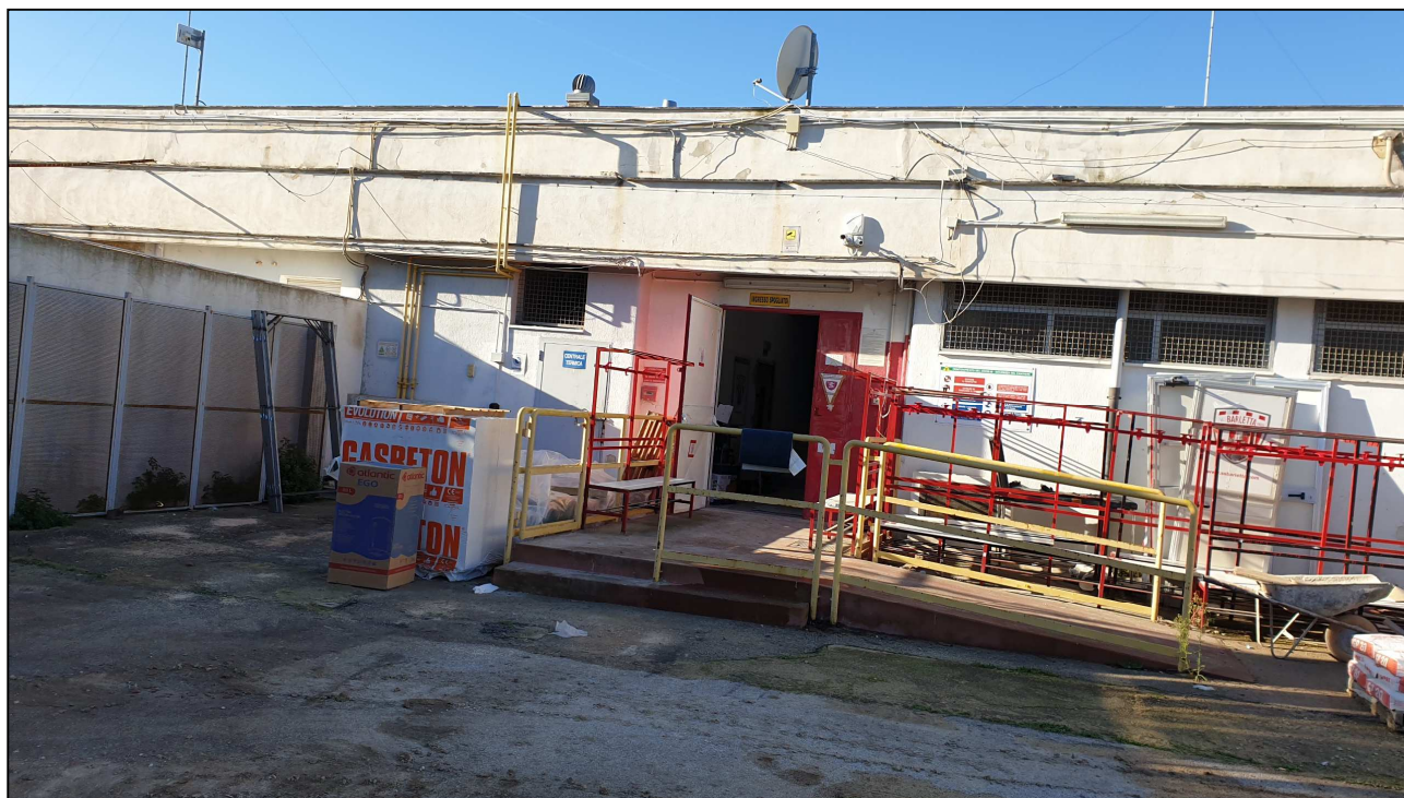
Fig. 5: vista dei bagni siti lungo il lato NORD-EST dello stadio
