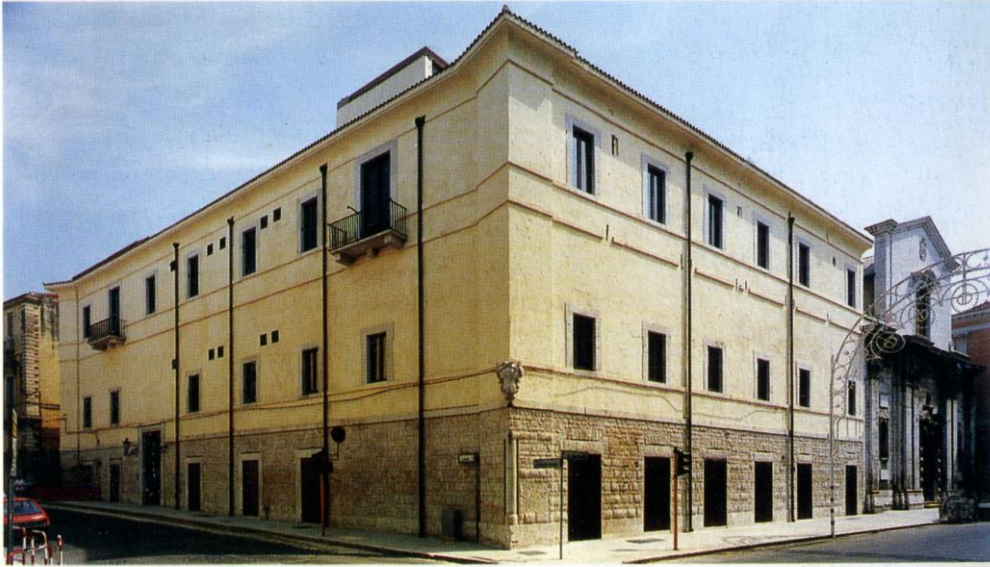
Tavv. 1-2. Veduta prospettica dell'ex convento di S. Domenico, prima e dopo il restauro.
