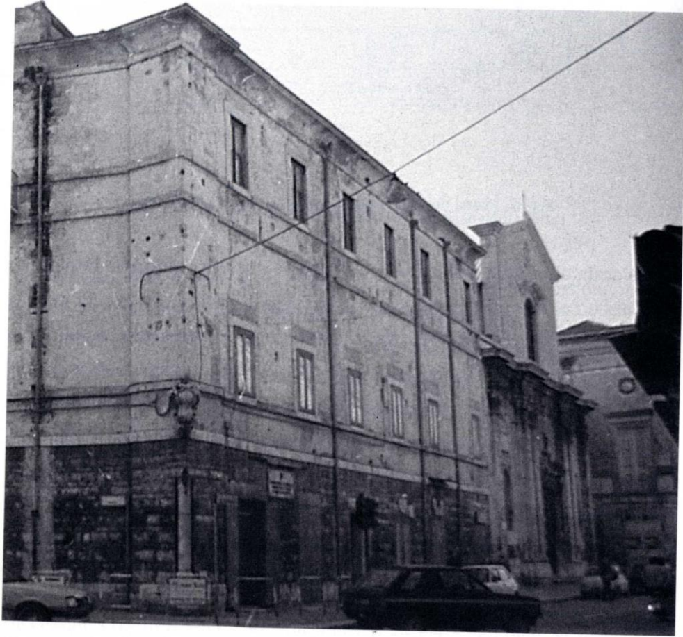
Figg. 33-34. Prospetto su corso Garibaldi.
