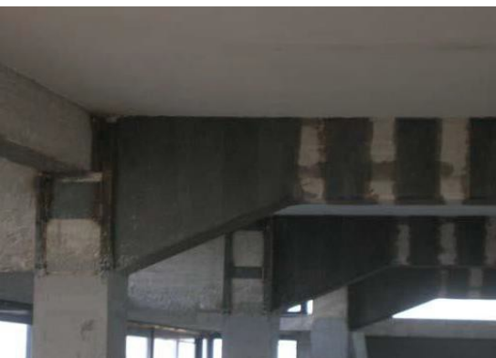
Fig. 3 - rinforzi per modificare il meccanismo di rottura
