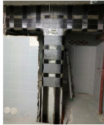
Fig. 2 - Rinforzo nodo-trave pilastro
