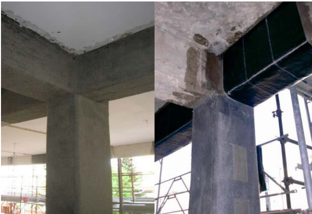
Fig. 3 - rinforzi per modificare il meccanismo di rottura
