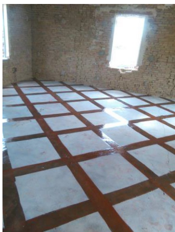
Fig. 7 - rinforzo solaio al fine di creare un piano rigido
