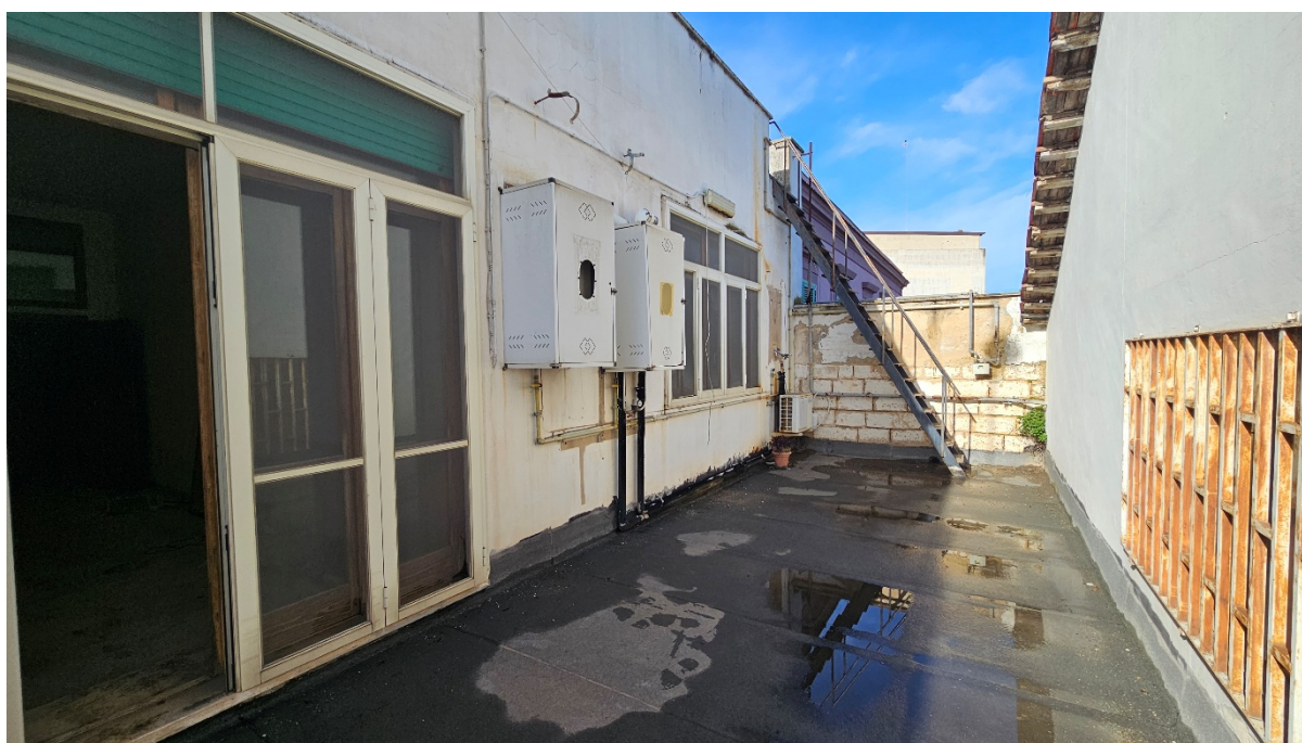
FOTO 14 terrazzino interno su cortile interno
