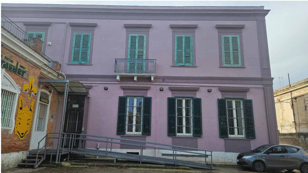
FOTO 1 ingresso da cortile interno con rampa di metallo
