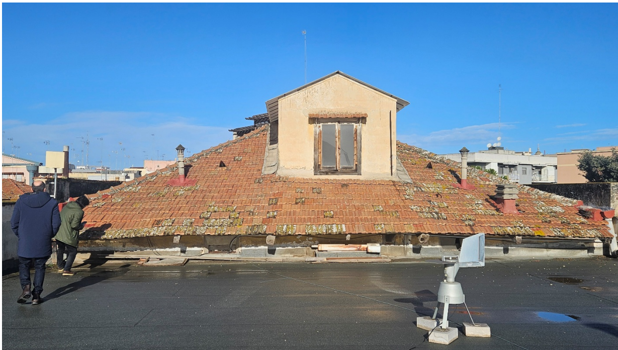
FOTO 15 terrazzo praticabile su palazzina nuova con vista tetto a falde palazzina Reichlin
