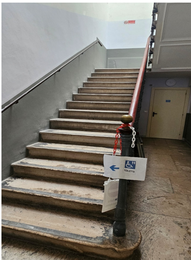
FOTO 3 accesso al piano primo con scala
