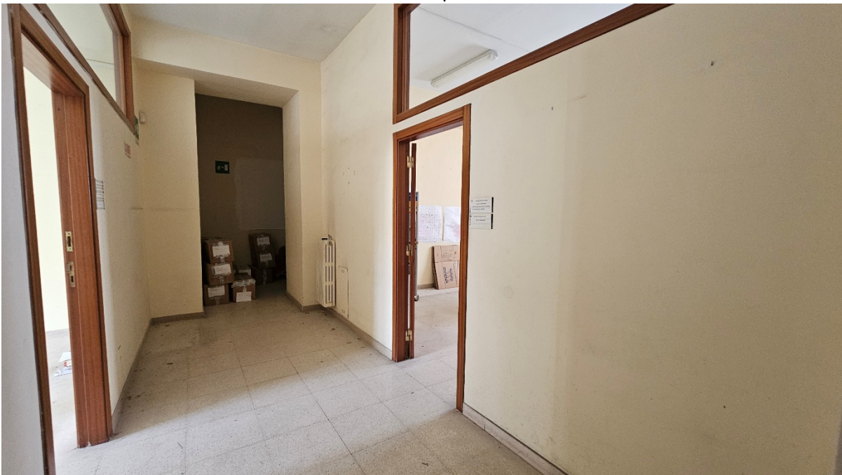
FOTO 10 disimpegno centrale palazzina adiacente Reichlin
