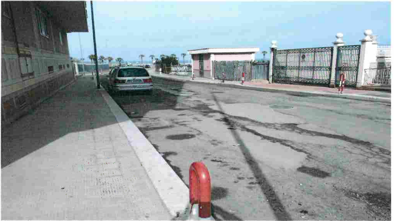
Vista delle aree da via Luigi Dicuonzo – Direzione Litoranea di Ponente La condottagira verso l'interno in aderenza alla cabina Enel a destra.
