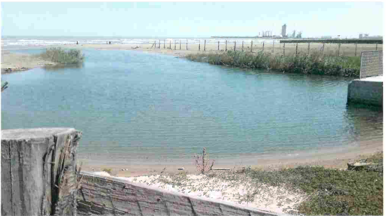
Vista laterale dello scarico
