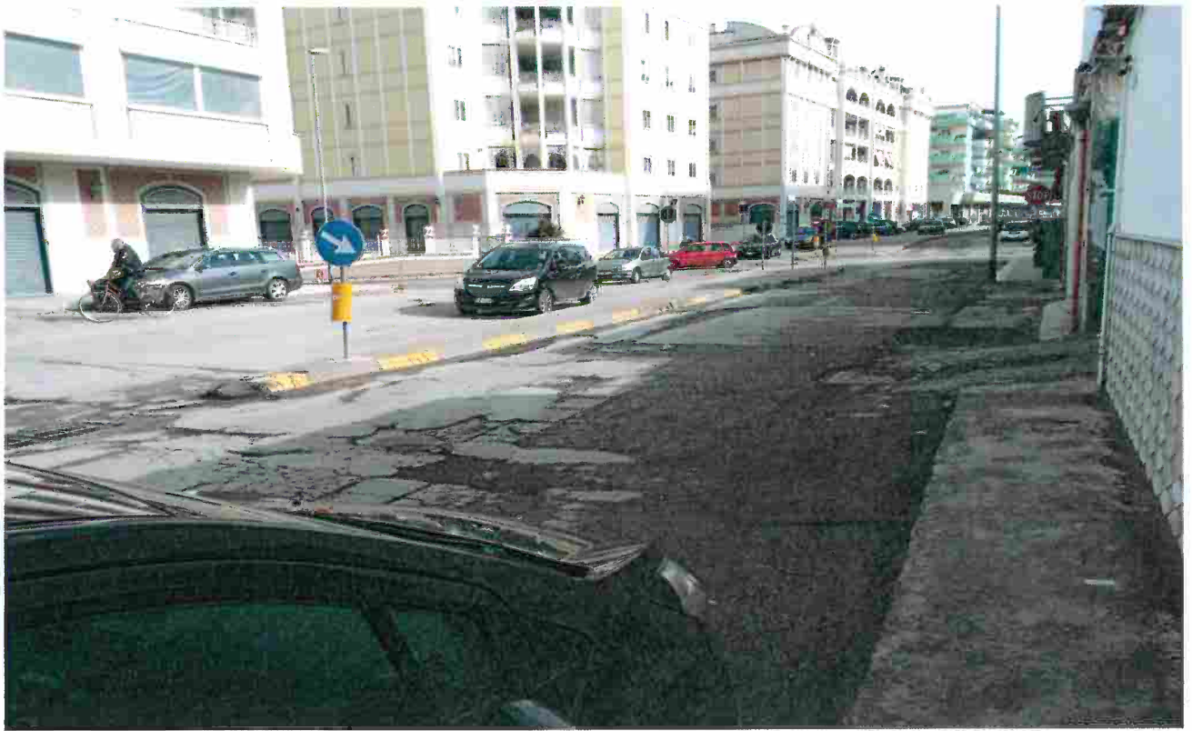
Vista delle aree da via del Gelso – Direzione via Ofanto- Incrocio con via L. Dicuonzo Derivatore DVR2
