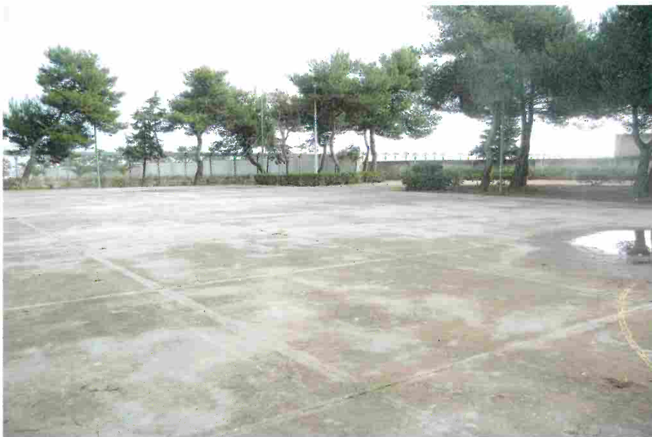
Interno scuola Modugno. L'impianto sarà ubicato sotto il campo polivalente che sarà parzialmente demolito e ricostruito.
