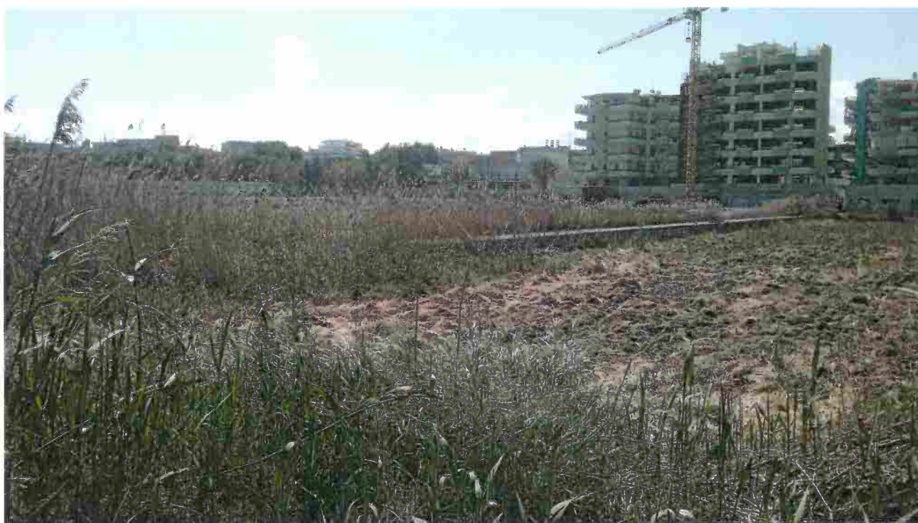
Collettore “B” – parte coperta e area interessata dall’impianto di trattamento
