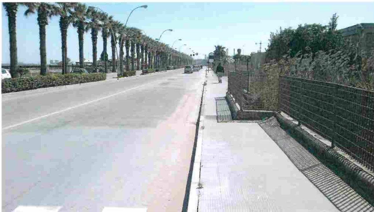
Vista del canale “H” che attraversa il lungomare
