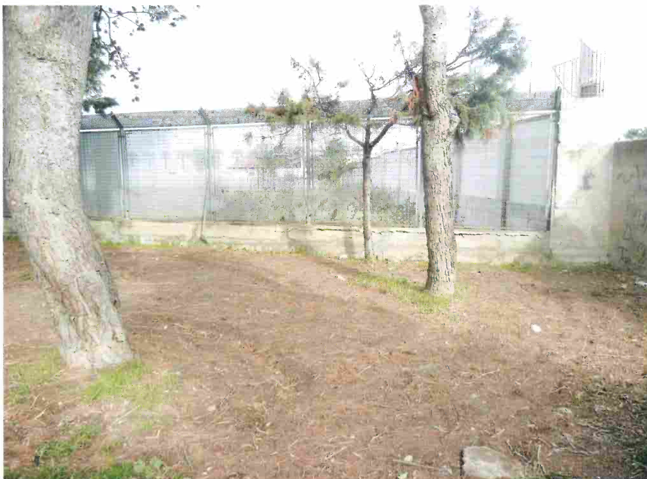
Particolare confine Nord-Est della recinzione della scuola
