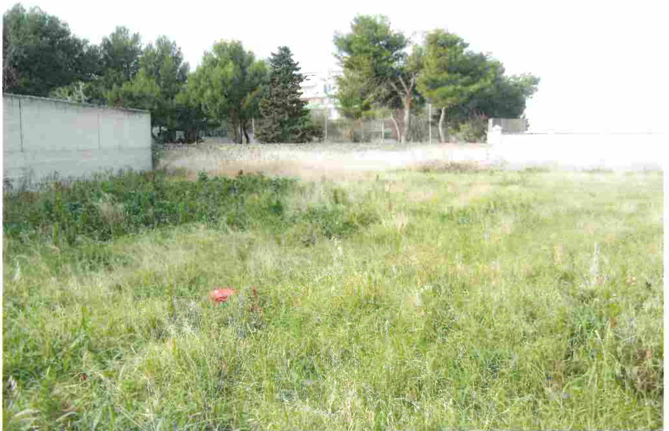
Prospetto del muro di confine della scuola visto da via Scommegna. Ingresso impianto in aderenza al muro di contenimento di sinistra
