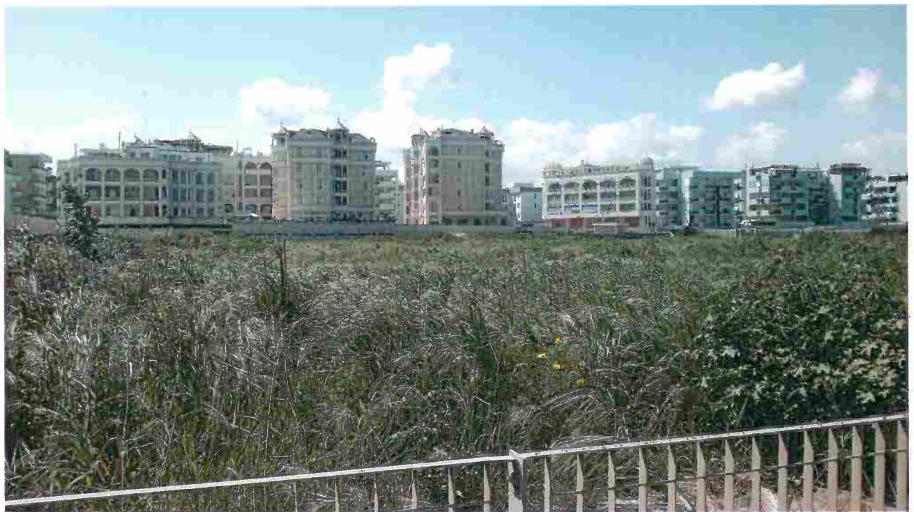
Vista delle aree dal Lungomare Pietro Mennea La condotta interrata dei derivatori sarà realizzata in prossimità del muro in c.a., che fa da confine con i fabbricati
