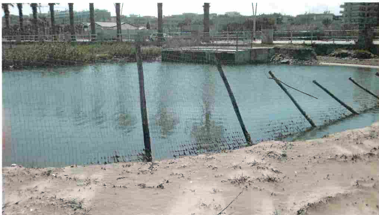
Vista frontale dello scarico
