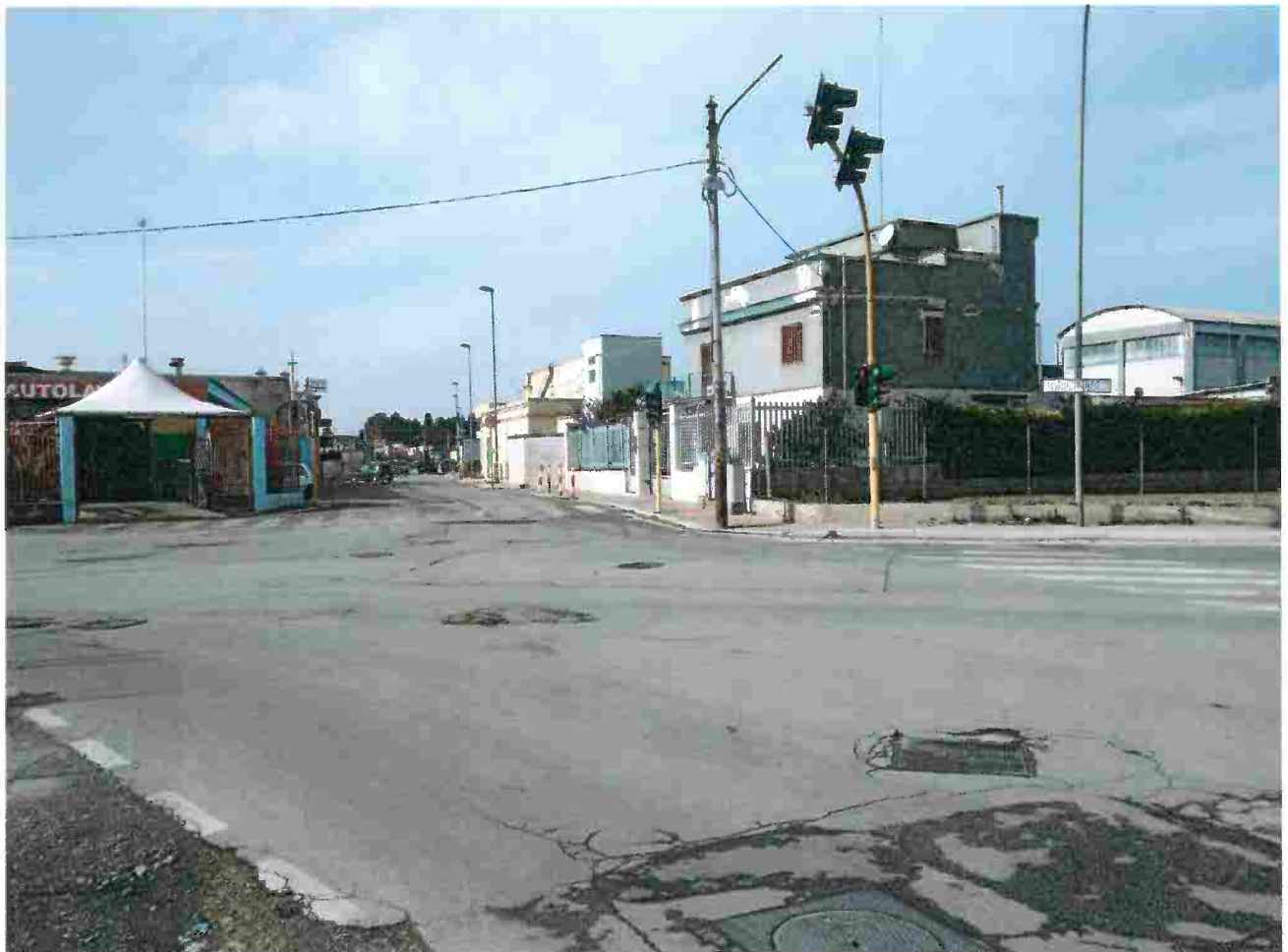
Vista delle aree da via del Gelso- incrocio via Violante Inizio condotta derivatore DVR1
