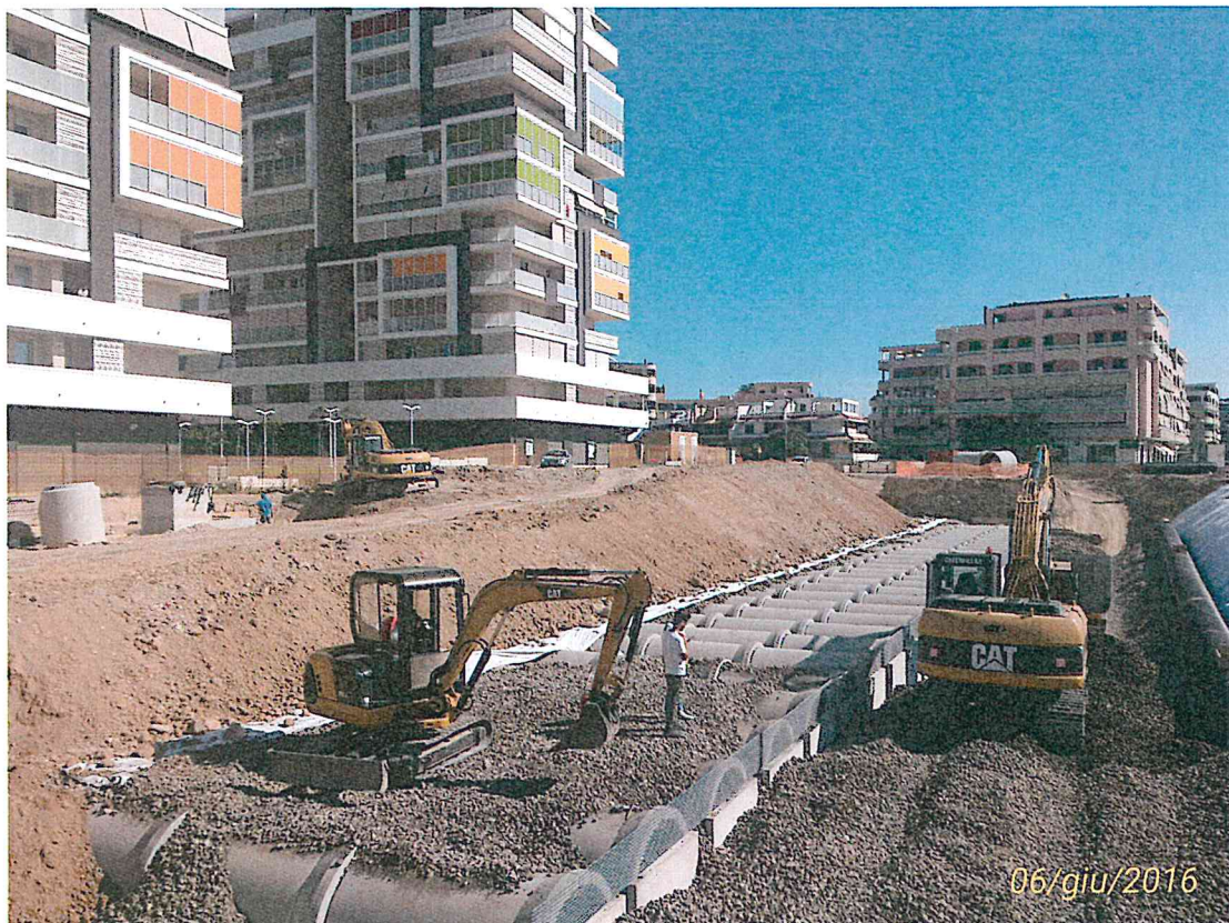
ESCAVATORINO PER DISTRIBUIRE LA GHIAIA E A SINISTRA PISTA CAMION PER LO SCARICO
