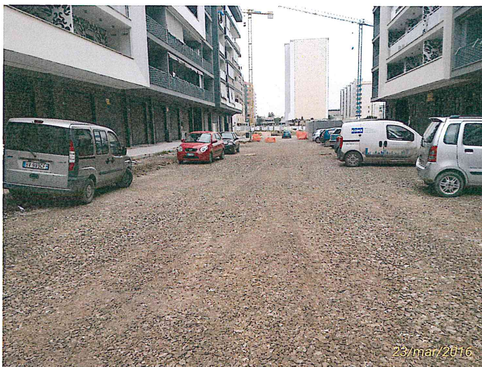
Strada del settore 2 sistemato con materiale di cava
