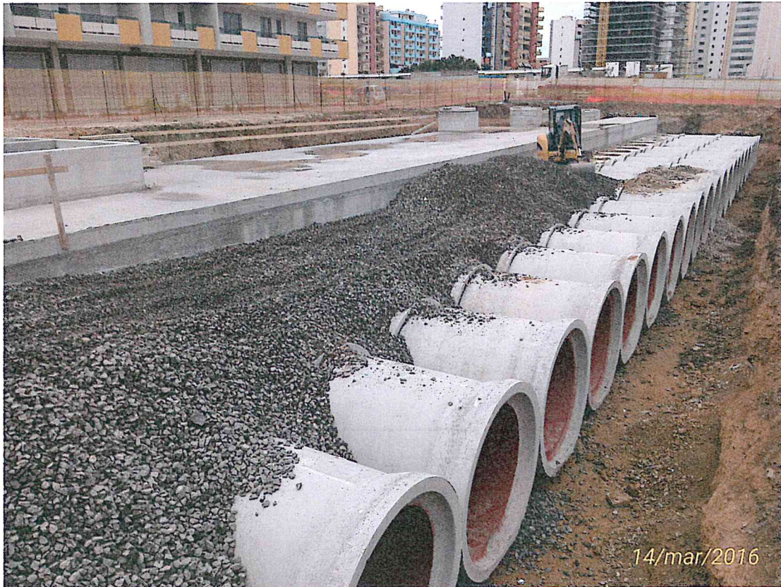
ESCAVATORINO PER DISTRIBUIRE LA GHIAIA E A SINISTRA PISTA CAMION PER LO SCARICO
