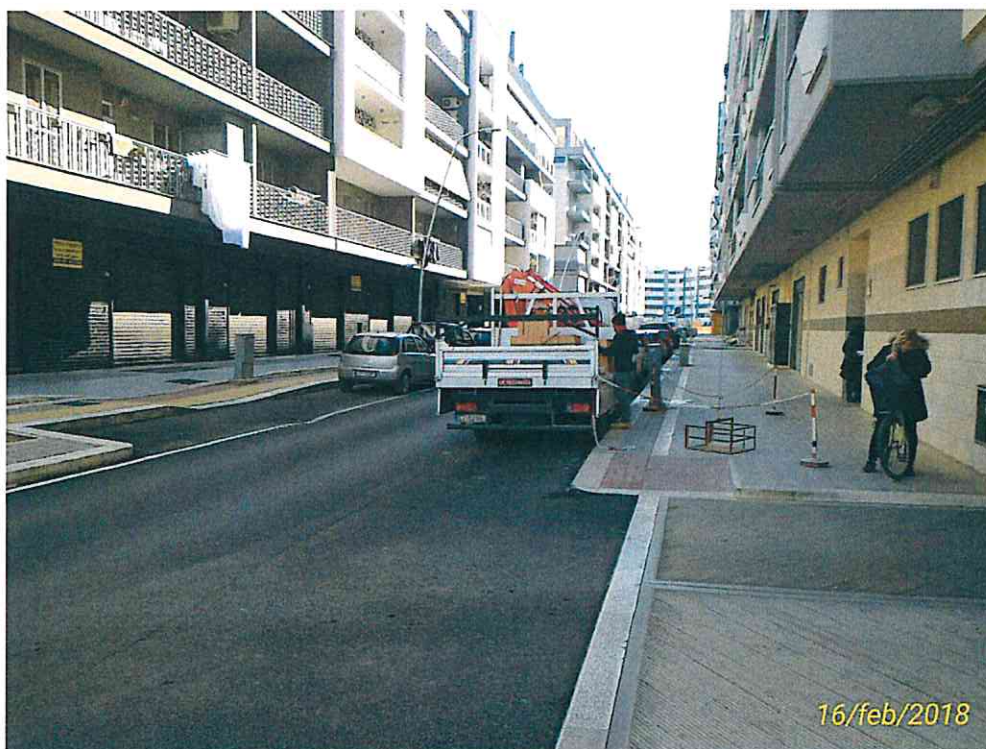
TRATTA 11 – TRA L TRAVERSE 71 E 72 CON MARCIAPIEDE DI CIRCA 60 CM CHE VEDE LA PRESENZA DI SOTTOSERVIZI DOVE NON E' STATO POSSIBILE COLLOCARE NEANCHE IL PERCORSO PER GLI IPOVEDENTI.
