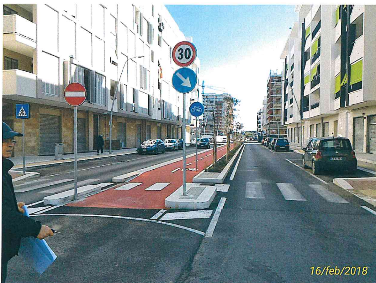
TRATTA CON FASCIA DI VERDE LATERALE DELLA LARGHEZZA DI CIRCA 60 CM CON LA MESSA A DIMORA DI OLEANDRI.
