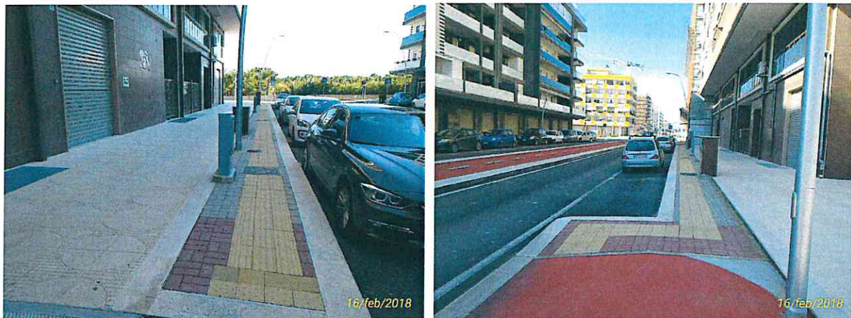
MARCIAPIEDI SULLA TRATTA 20 TRA LE TRATTE E 84 E 103 DOVE E' STATO IMPOSSIBILE PORRE A DIMORA LE ALBERATURE PREVISTE IN PROGETTO
