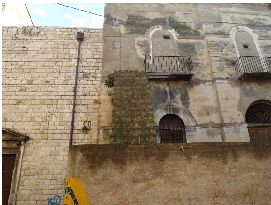
Foto in cui sono visibili il contrafforte e i capochiave delle catene
