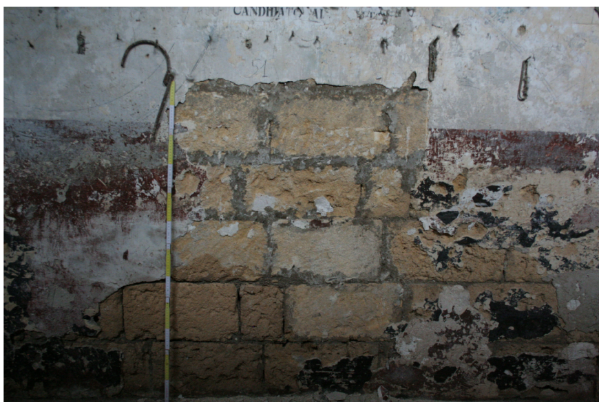
Saggio della muratura finalizzato alla valutazione della tipologia
