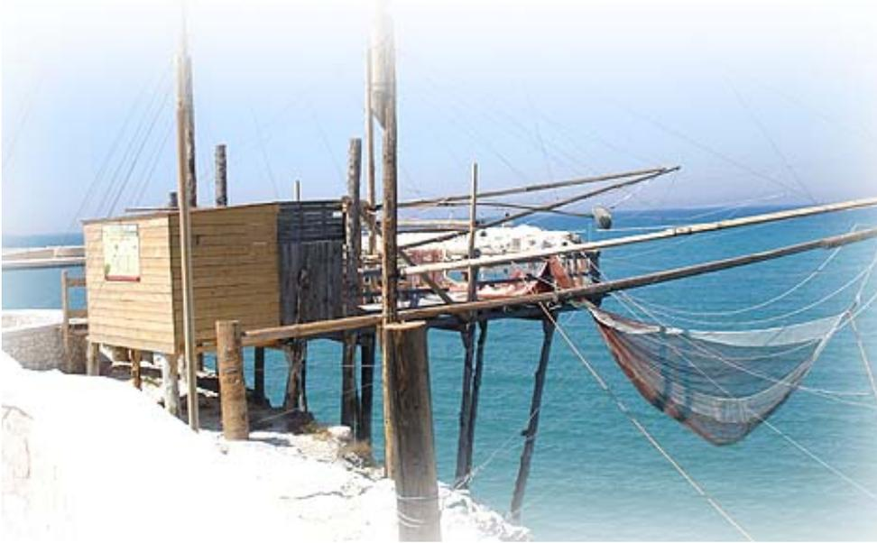
La tecnica di costruzione è in sé parte fondamentale dell'organismo architettonico e la sua leggibilità conferisce la caratteristica del manufatto. Pertanto tutti gli elementi strutturali e i sistemi di unione e fissaggio sono visibili integralmente.
