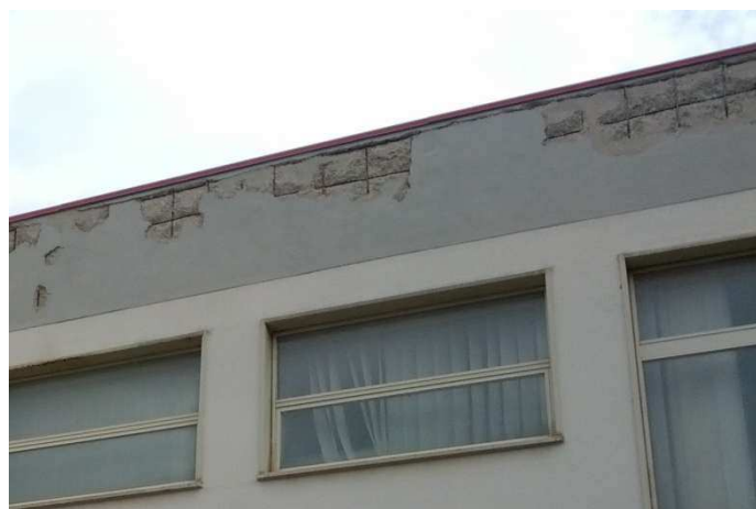
Scuola Statale Primaria G. Modugno – Degrado intonaco - cls
