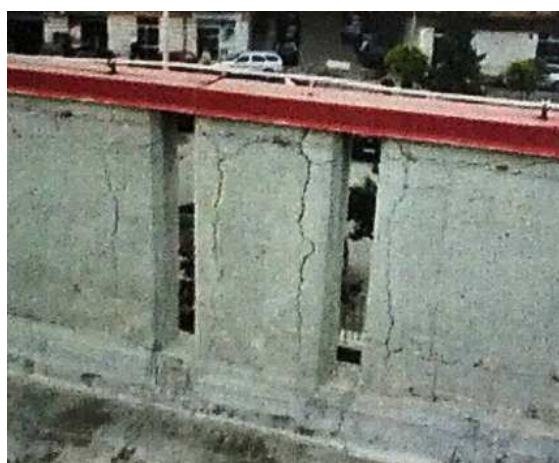
Scuola Statale Primaria G. Modugno – Degrado intonaco - cls
