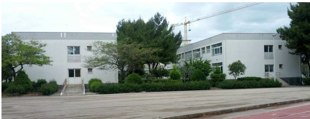
Scuola Statale Primaria G. Modugno – Prospetto laterale (Sud-est)
