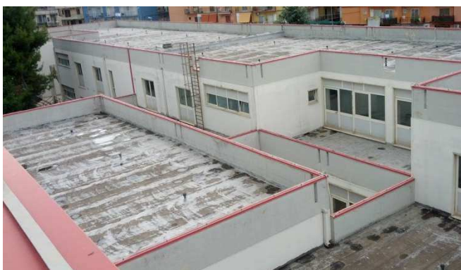
Scuola Statale Primaria G. Modugno – Impermeabilizzazioni coperture
