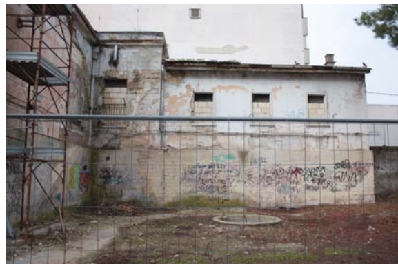
5 Aggiunta successiva, ex Alloggio del custode
