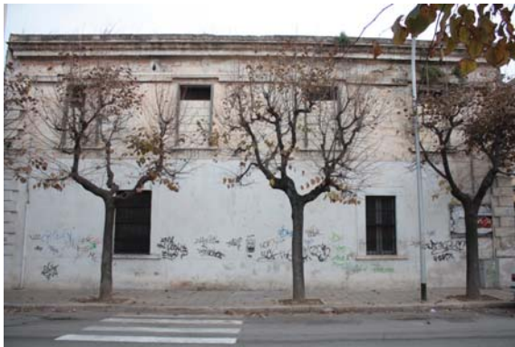
2 Il fronte dell'edificio su Viale Marconi
