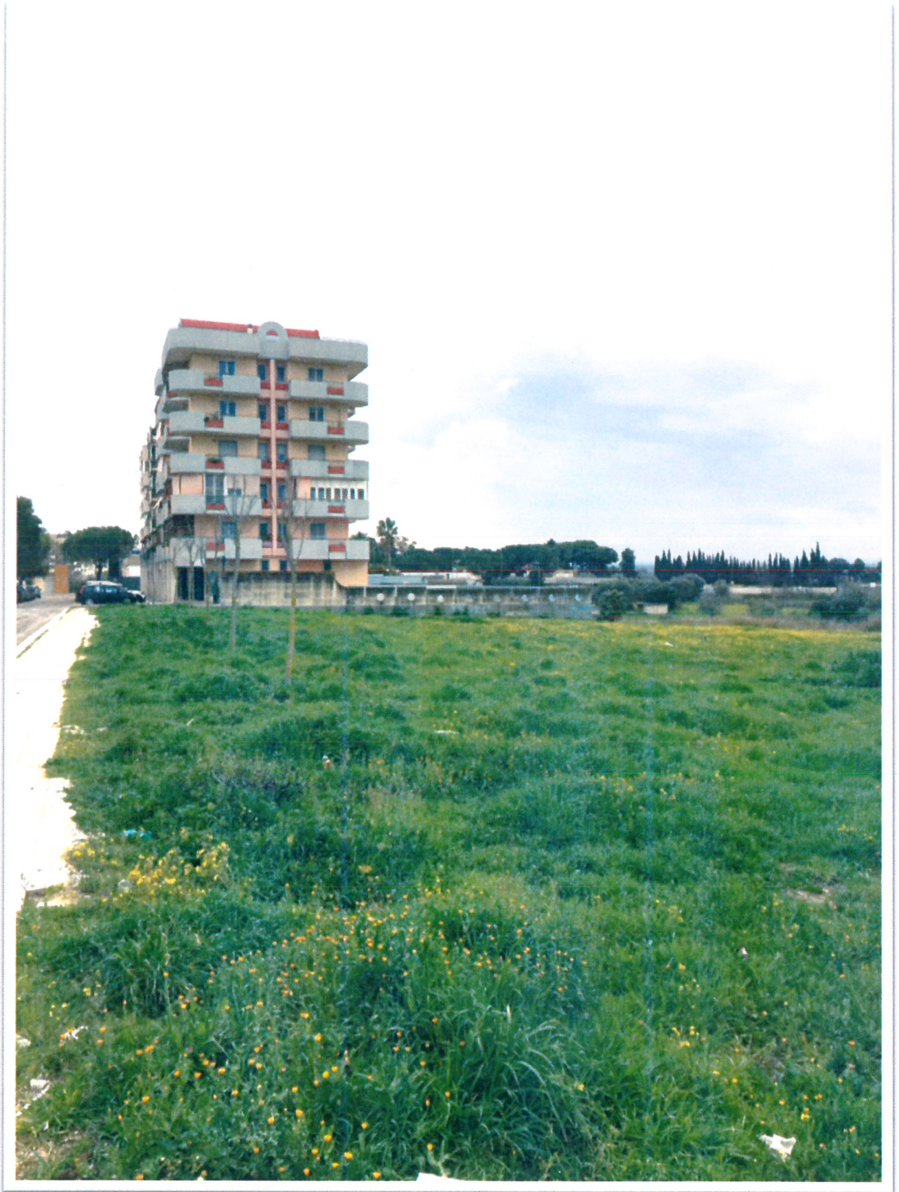
Foto area intervento direz. SUD
