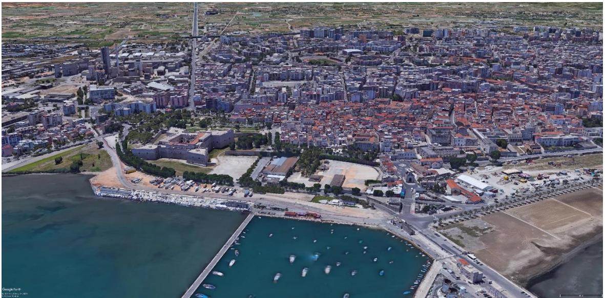
Figura 2: foto area dell'esistente (fonte Google earth)
