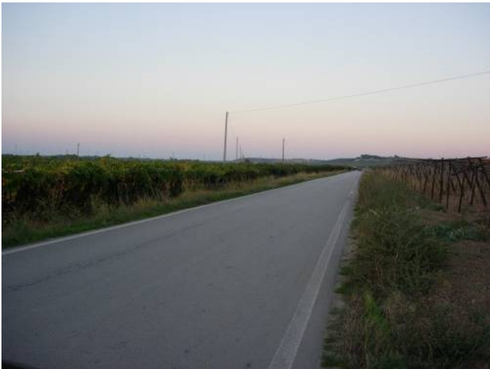
Strada Salinelle in corrispondenza della Stazione Casalunga
