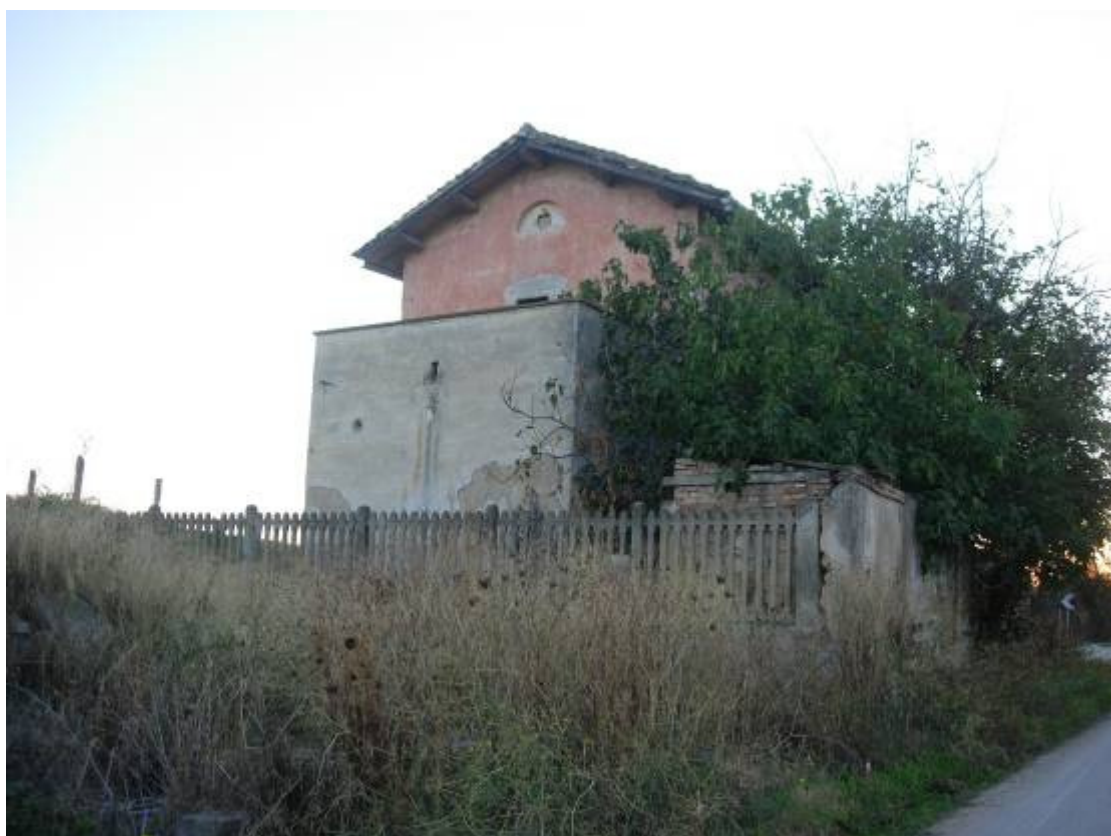
Edificio di pertinenza della Stazione
