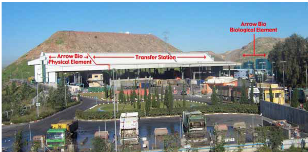
Figura 1. L'impianto ArrowBio presso la stazione di trasferimento di Tel Aviv, Israele. Il sottosistema meccanico dell'impianto per la separazione/preparazione si trova sotto il tetto a sinistra, mentre il sottosistema biologico si trova al di là del tetto a destra. Sullo sfondo è visibile la discarica di Hiriya, attualmente chiusa ed in fase di bonifica per diventare parte del futuro Parco Ayalon.
